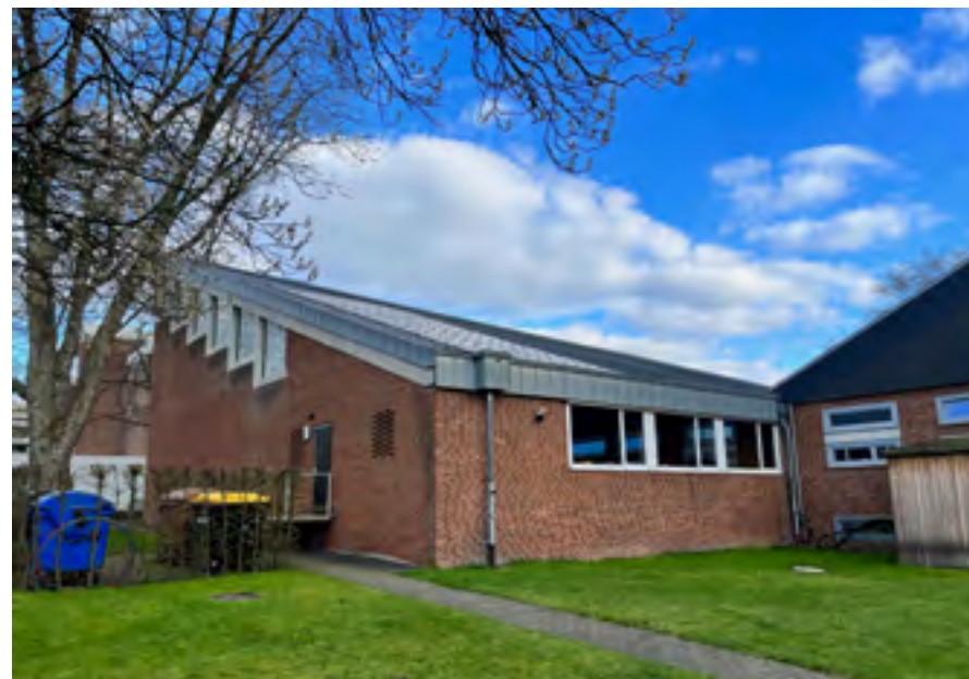
Photovoltaik an der Friedenskirche
